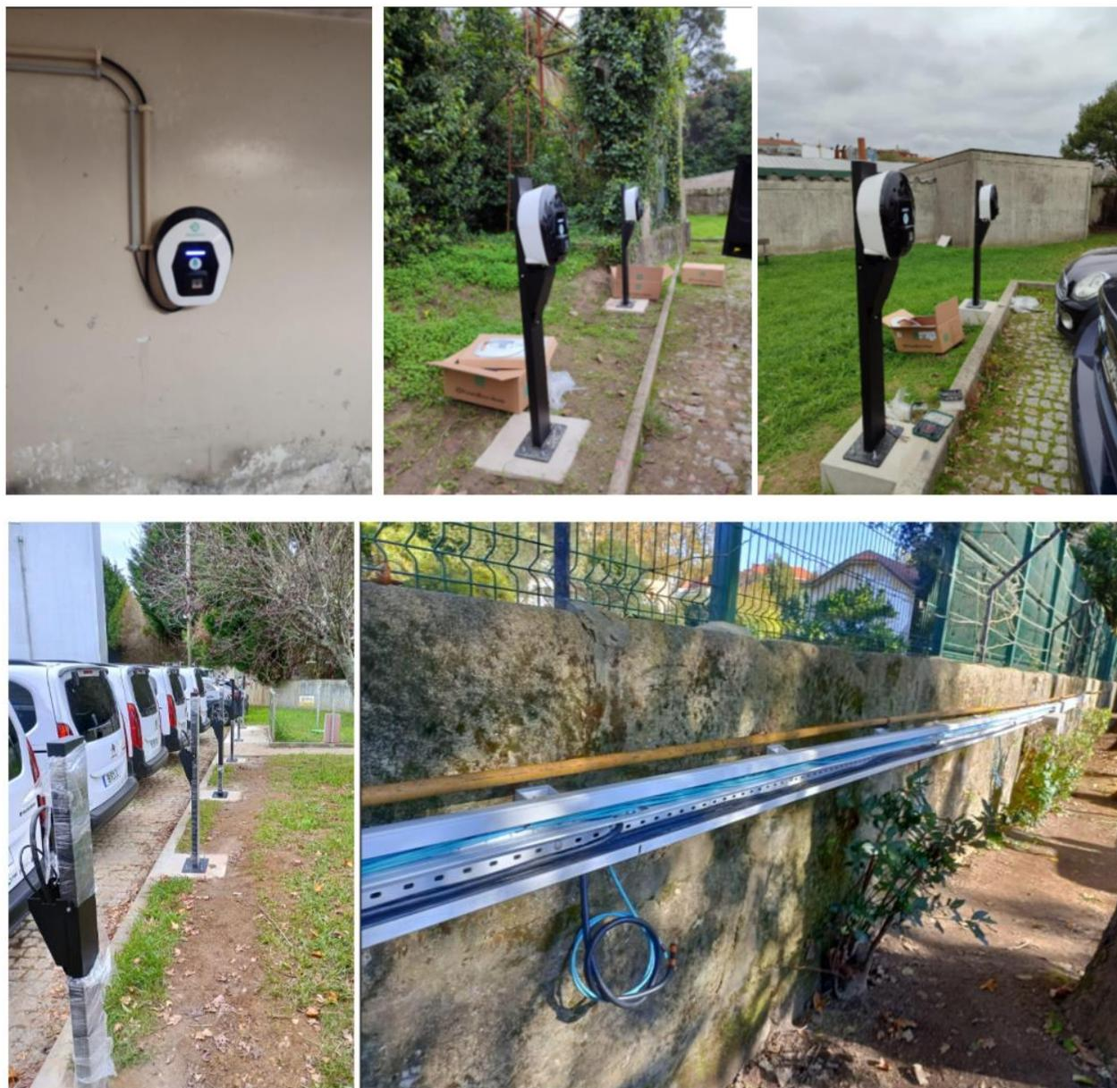
Figura 10 - Instalação das Wallbox nos diferentes edifícios
