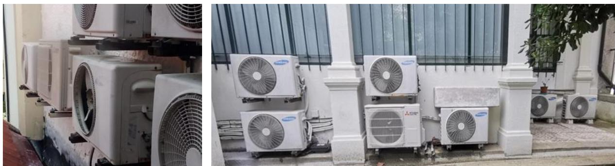
**Figura 8** - Equipamentos de A/C no Edifício da Foz, antes e após intervenção
