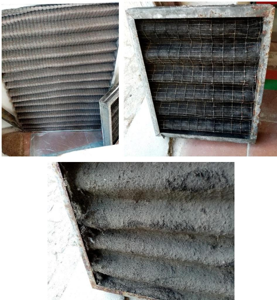
**Figura 7** - Filtros de Equipamentos do Edifício CDP/Serpa Pinto inoperacionais, dado o estado completamente colmatado
